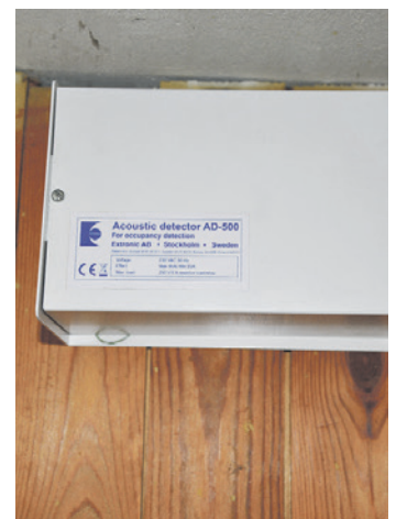
Modtagerboksen i kælderen reagerer på lyd, hvilket sparer energi og sikrer tryghed.
