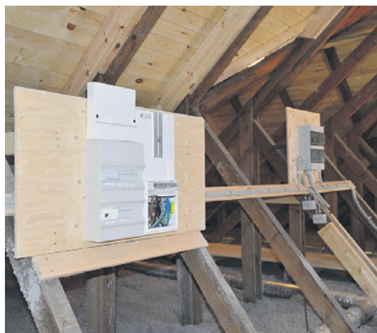
På loftet er fællestavlerne og sektionsafbrydere udskiftet, så elforsyningen til lejlighederne nu stemmer overens med nutidens forbrugsmønstre.
