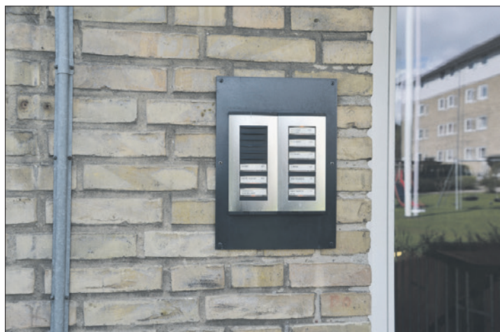
Beboerne har blandt andet fået udskiftet dørtelefonssystemet, som tidligere havde meget støj på forbindelsen.
